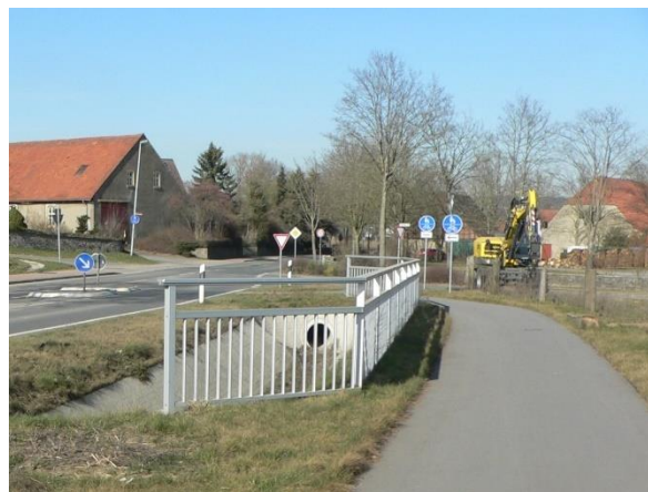
„Lüstringer Straße“ (K 321) vor Einmündungsbereich mit „Natberger Straße“
